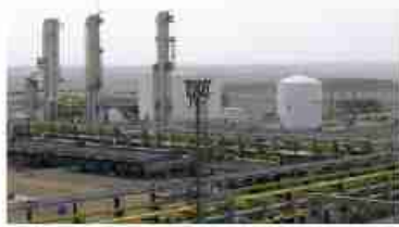
محطة تنقية مياه شكل (١٥)
